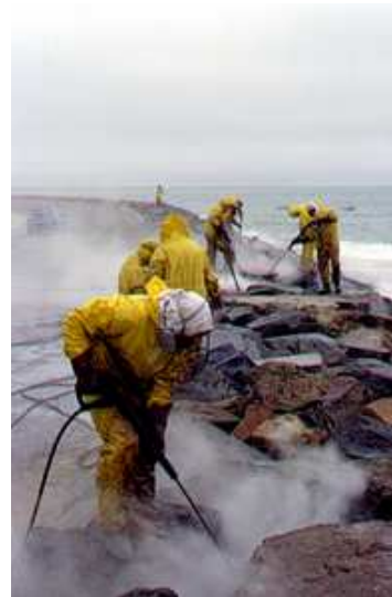
Figura A15.6 Aplicació d'aigua calenta a pressió (Font: CEDRE)
